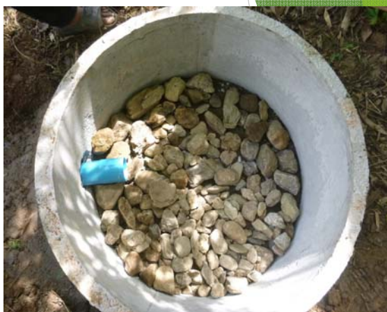
เชื่อมต่อท่อกับบ่อกรองน้ำ
