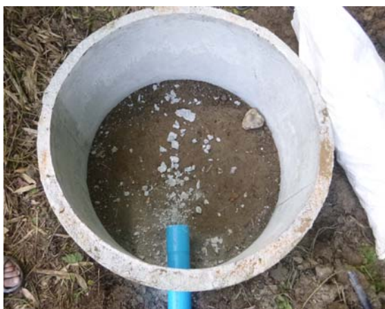
เชื่อมต่อท่อกับบ่อกรองน้ำ
