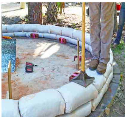
Figure 7. Une fois que tous les sacs d'une couche ont été mis en place, le tassement aplatit, nivelle et fixe les sacs.
