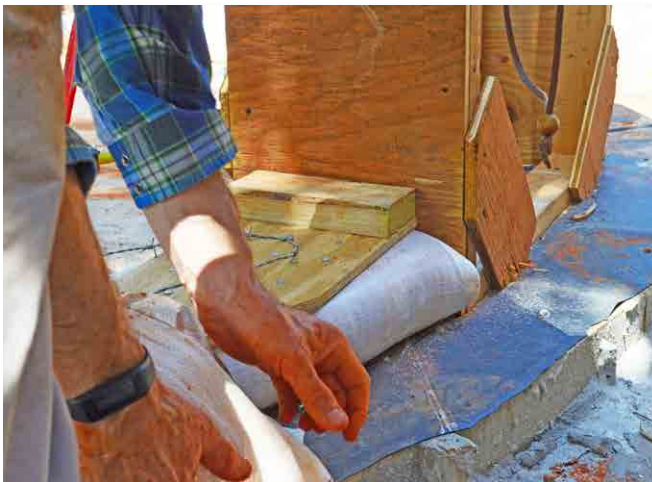
Figure 4. Plaque Velcro placée au-dessus de la première rangée en sacs de terre (à gauche) et coupe illustrée d'une plaque Velcro mise en place (à droite).
