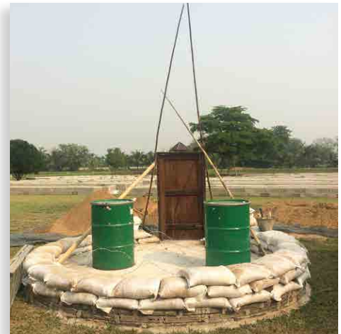
Figure 3. Armatures de porte fixées sur le site de ECHO en Floride (en haut) et en Thaïlande (en bas). Source: Cody Kiefer (en haut) et Patrick Trail (en bas).
