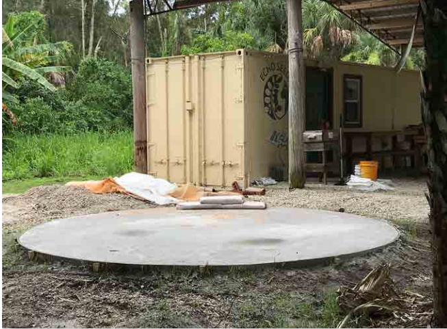
Figure 2. Fondation de la dalle de béton de ECHO en Floride pour une banque de semences en sacs de terre (à gauche) et coupe illustrée (à droite).
