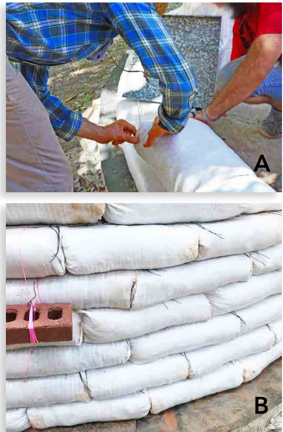
Figure 6. (A) Placement d'un sac de terre en le faisant glisser à l'aide d'un glisseur. Remarquez que les sacs sont fermement placés les uns contre les autres. Le membre du personnel, Elliott Toevs, est également en train de faire le diddling des coins avant de passer au sac suivant. (B) Remarquez les joints verticaux, chose importante pour assurer l'intégrité structurelle des édifices en sacs de terre.
