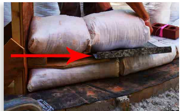
Figure 9. Gros plan de l'utilisation du glisseur dans le placement des sacs. Source: Tim Motis.
