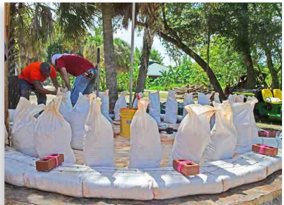
Figure 5. Des sacs remplis sont placés le long du périmètre de la couche en préparation du placement. Remarquez le poteau dans le seau orange, utilisé en combinaison avec une ficelle pour placer chaque sac à la même distance (rayon du cercle) du centre de l'édifice.
