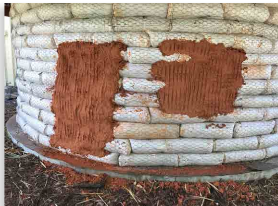
Figure 14. Une comparaison des mélanges d'enduit sur la banque de semences qui se trouve sur le site de ECHO en Floride.
