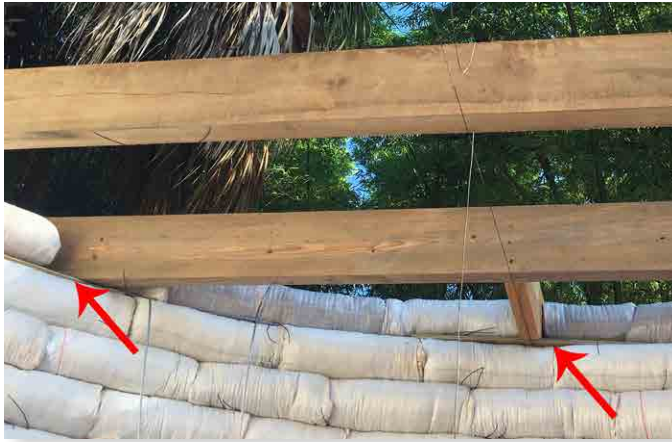
Figure 12. Des solives de plafond et un connecteur à chevrons sont intégrés dans la quatrième couche à partir du haut sur le site de de ECHO en Floride. Source: Tim Motis.
