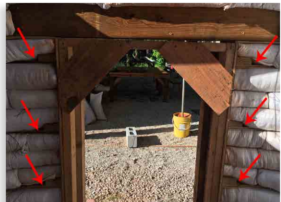
Figura 11. Las flechas indican la colocación de la placa de velcro después de cada tercera capa. Fuente: Tim Motis.
