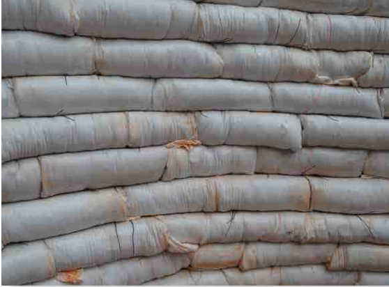
Figura 10. Observe la unión en hileras y las costuras verticales, así como los alambres de amarre que sobresalen entre las capas. El ladrillo colgante mantuvo el alambre de púas en su lugar hasta que fue desplazado por un saco de tierra; la cuerda ayuda a mantener los ladrillos cerca del nivel de trabajo de la construcción en lugar de tener que colocar y recoger los ladrillos.
