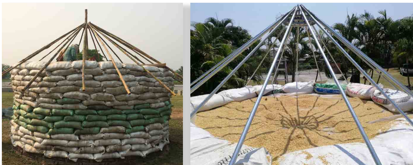
Figura 13. La oficina de ECHO en Tailandia instaló inicialmente una estructura de techo a base de bambú (izquierda) que después fue sustituida por una estructura metálica (derecha). Fuente: Patrick Trail.
