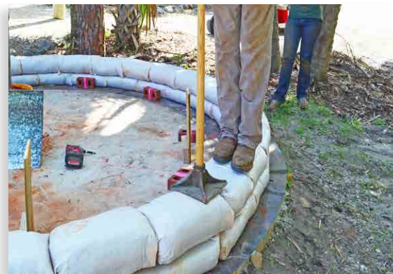
Figura 7. Después de que todos los sacos de una capa están en su lugar, al apisonarlos se aplanan, nivelan y fijan.
