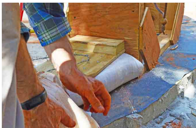
Figura 4. Placa de velcro colocada encima de la primera capa de sacos de tierra (izquierda), y sección transversal ilustrada de una placa de velcro en su lugar (derecha).
