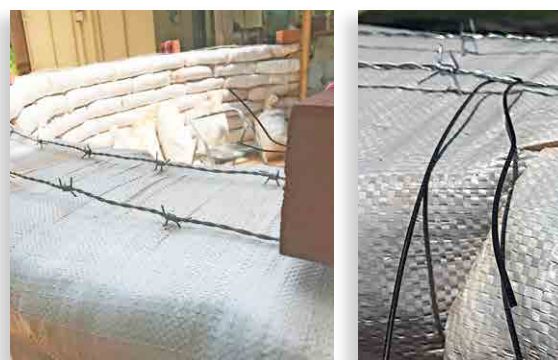
Figura 8. Primer plano del alambre de púas (arriba) y de los alambres de amarre (derecha) sobre los sacos de tierra apisonados. Los ladrillos mantienen el alambre de púas en su lugar mientras se coloca la siguiente capa.
