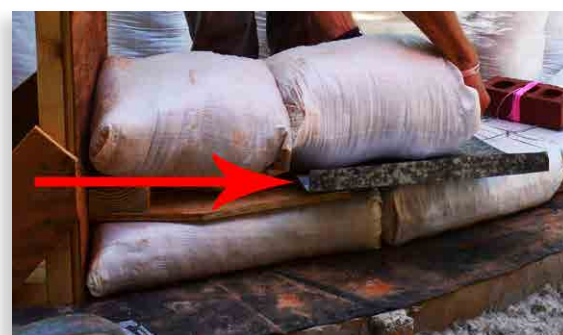
Figura 9. Primer plano del uso de la lámina deslizadora en la colocación del saco. Fuente: Tim Motis.
