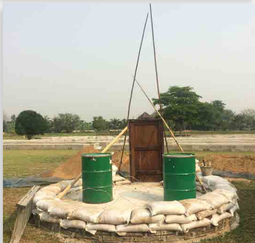
Figura 3. Formaletas de puerta colocadas en la localidad de ECHO en Florida (superior) y en la oficina en Tailandia (fondo). Fuente: Cody Kiefer (superior) y Patrick Trail (fondo).
