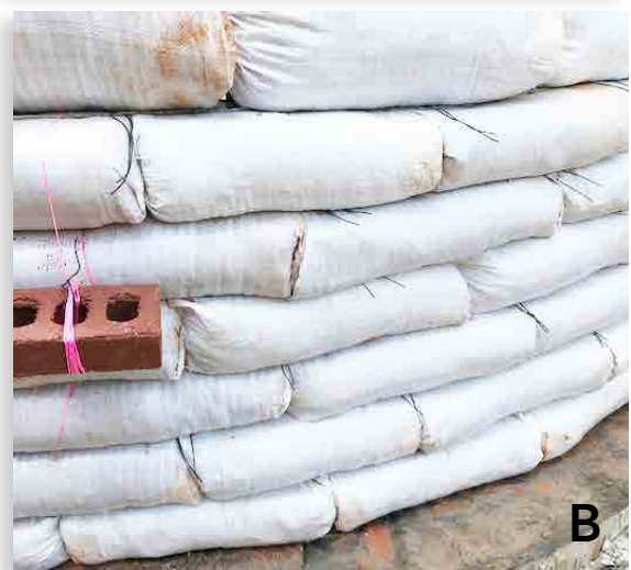
Figura 6. (A) Deslizar un saco de tierra en su lugar usando una lámina deslizador. Observe que los sacos están colocados firmemente uno contra el otro. El miembro del personal, Elliott Toevs, también está haciendo el truco de invertir las esquinas doblándolas hacia adentro antes de pasar al siguiente saco. (B) Observe las costuras verticales, importantes para asegurar la integridad estructural de las estructuras de los sacos de tierra.
