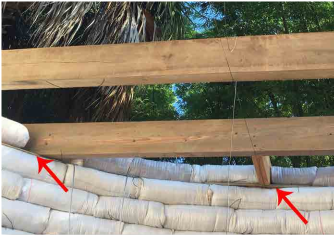
Figura 12. Las vigas del techo y el amarre de las vigas se trabajan en la cuarta capa desde la parte superior en la localidad de ECHO Florida. Fuente: Tim Motis.
