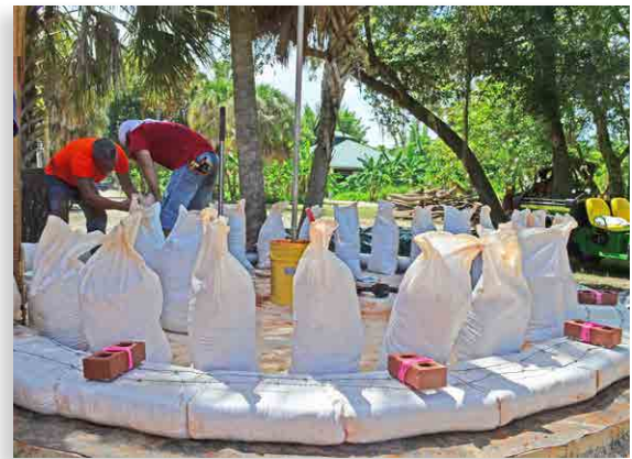
Figura 5. Los sacos llenos se colocan a lo largo del perímetro del trabajo de las capas en preparación a la colocación. Observe el poste en el cubo naranja, usado en combinación con una cuerda para colocar cada bolsa a la misma distancia (radio del círculo) del centro de la estructura.
