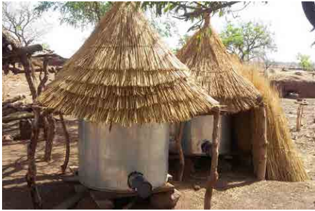
Figura 12. Silos metálicos terminados con techo para protegerlos de los elementos. Fuente: Edward Martin
