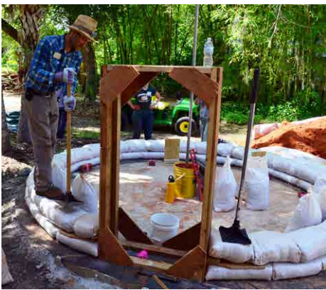
Figure 7. Entassement de sacs pour former les murs d'une maison en sacs de terre. Source: Cody Kiefer
