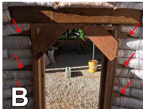
Figure 9. Point de fixation en bois (A), entre chaque troisième couche de sacs (B), auquel le chambranle a été fixé. Source: Cody Kiefer (A) et Tim Motis (B)
