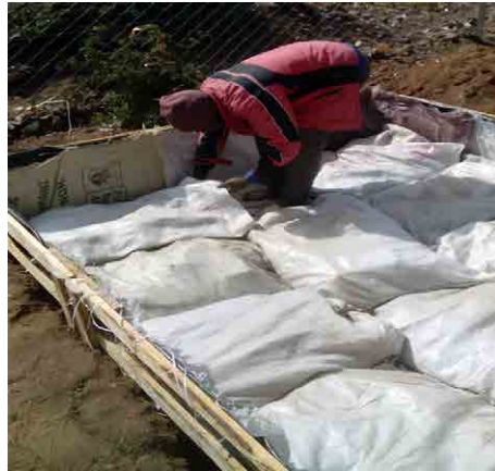
Figure 1. Incorporation de matériaux de remblayage dans le réservoir d'eau d'un jardin centuple. Source: Lance Edwards
