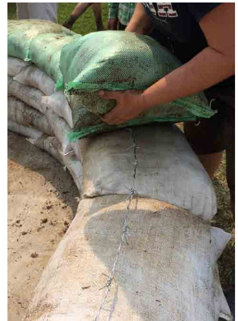
Figure 5. Placement d'un sac rempli de terre sur le mur d'une maison en sacs de terre. Source: personnel de ECHO Asie
