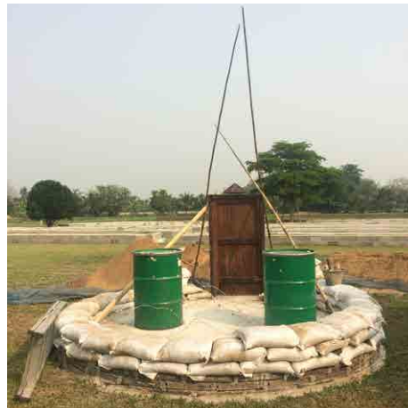
Figure 4. Fondation d'une maison en sacs de terre sur le site de ECHO en Asie. Source: personnel de ECHO Asie
