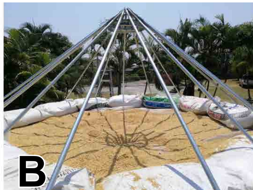
Figure 10. Le bambou (A) et le métal (B) comme choix pour les chevrons. Remarquez la balle de riz sur le plafond en contreplaqué comme isolant. Source: Personnel de ECHO Asie
