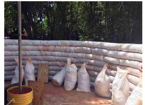
Figure 6. Pôle de mesure de la distance entre chaque sac et le centre d'une maison en sacs de terre circulaire. Source: Cody Kiefer
