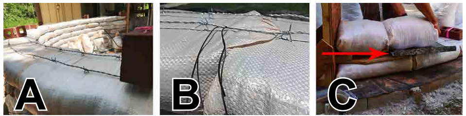
Figure 8. Fil de fer barbelé (A) et fil de ligature liés à un fil de fer barbelé (B) pour imbriquer les composants du mur d'une maison en sacs de terre. La photo montre une pièce de tôle utilisée pour empêcher les sacs de s'accrocher aux fils de fer barbelés pendant la pose. Source: Cody Kiefer
