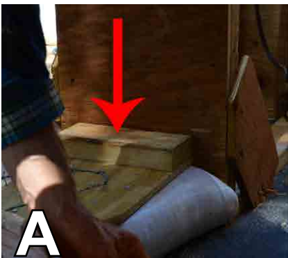
Figure 9. Point de fixation en bois (A), entre chaque troisième couche de sacs (B), auquel le chambranle a été fixé. Source: Cody Kiefer (A) et Tim Motis (B)
