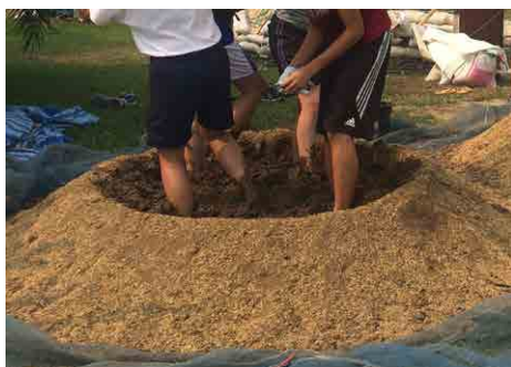
Figure 11. Mélange d'enduit pour recouvrir les murs d'une maison en sacs de terre. Source: Personnel de ECHO Asie
