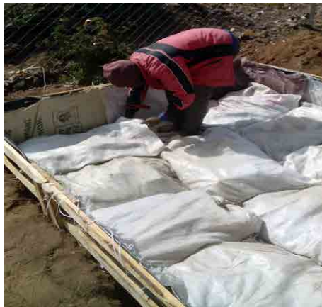
Figura 1. Incorporación de material de relleno en el reservorio de agua de un huerto centuplicado. Fuente: Lance Edwards
