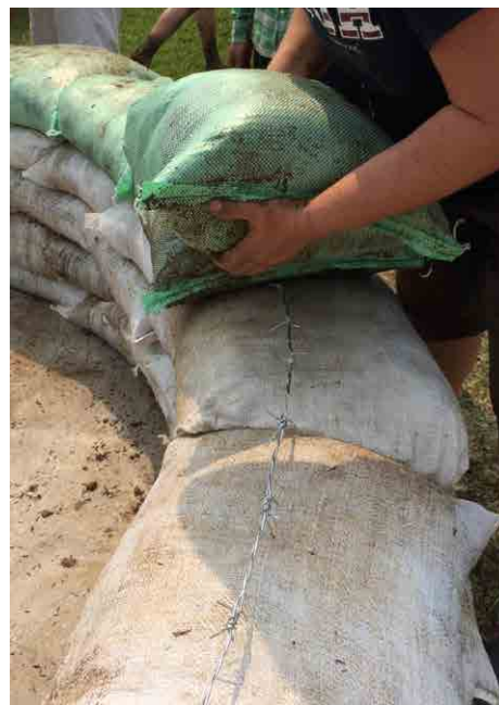
Figura 5. Colocando un saco lleno de tierra en una pared de casa de sacos de tierra. Fuente: Personal de ECHO Asia
