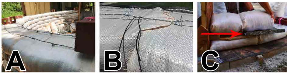
Figura 8. Alambre de púas (A) y alambre de metal amarrado a alambre de púas (B) para entrelazar los componentes de la pared de sacos de tierra. La Foto C muestra una pieza de lámina metálica para impedir que los sacos se agarren al alambre de púas durante la colocación. Fuente: Cody Kiefer
