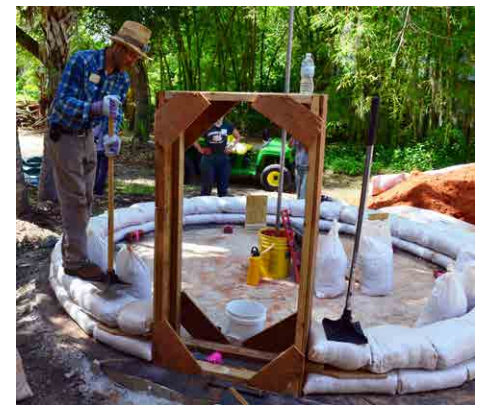
Figura 7. Apisonando sacos para formar paredes de una casa de sacos de tierra. Fuente: Cody Kiefer
