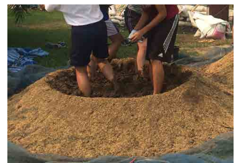
Figura 11. Mezclando repello para cubrir las paredes de una casa de sacos de tierra. Fuente: Personal de ECHO Asia
