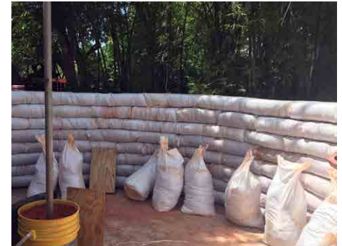
Figura 6. Poste para medir la distancia de cada saco del centro de una casa de sacos de tierra circular. Fuente: Cody Kiefer
