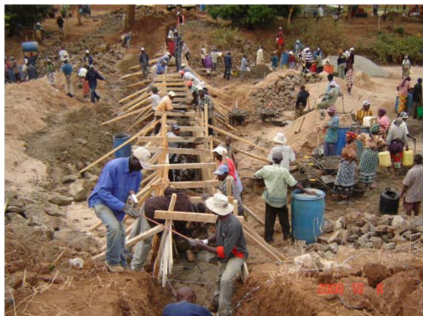
Figure 5 : Construction d'un barrage de sable à Woni Wo Tithi par des GE d'Emali et des employés d'UDO, Kenya
