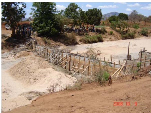
Figure 6 : Cure d'un barrage de sable nouvellement construit, Woni Wo Tithi, Kenya
