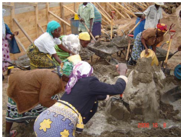
Figure 4 : Des membres de la communauté mélangent le mortier à Woni Wo Tithi, Kenya
