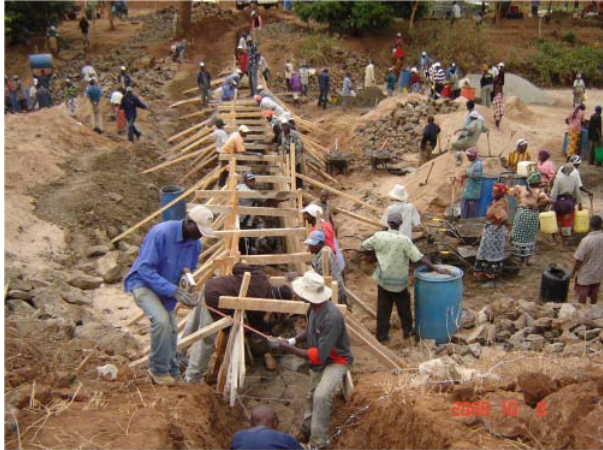
Figura 5: construcción de presa de arena en Woni Wo Tithi por SHG de Emali y personal de UDO, Kenia
