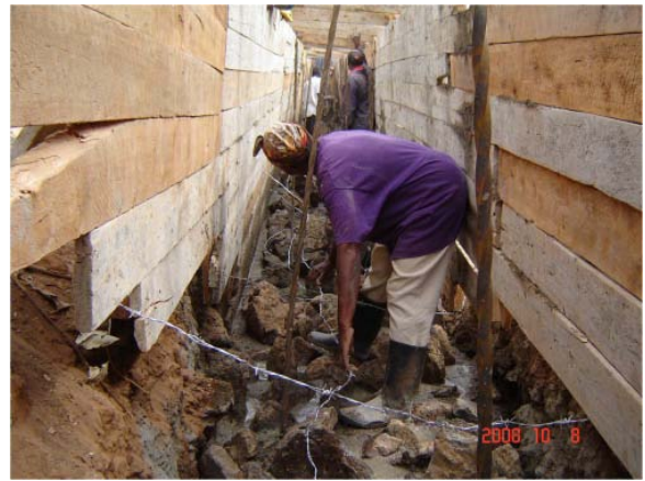
Figura 3: Artesano en zanja mostrando encofrado, varillas retorcidas de hierro y alambre de púas.
