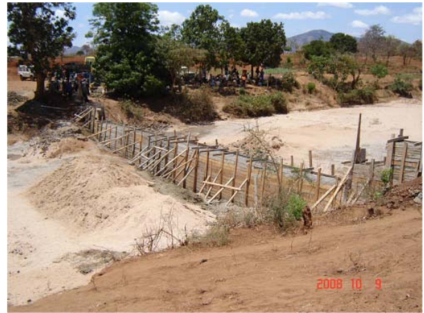
Figura 6: presa de arena terminada en el proceso de fraguado, Woni Wo Tithi, Kenia
