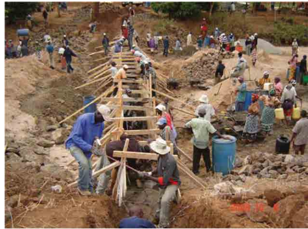
Figure 5. Construction d'un barrage de sable à Woni Wo Tithi par des groupes d'entraide d'Emali et le personnel de l'UDO au Kenya.
