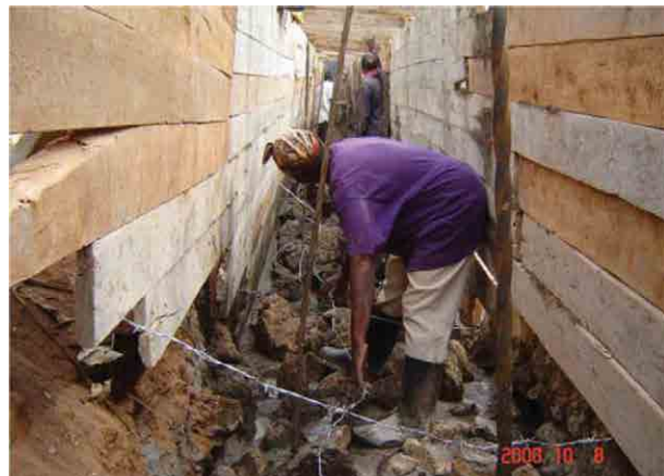
Figure 3. Un artisan dans la tranchée montrant le coffrage, les barres d'armature en acier et les fils de fer barbelés.
