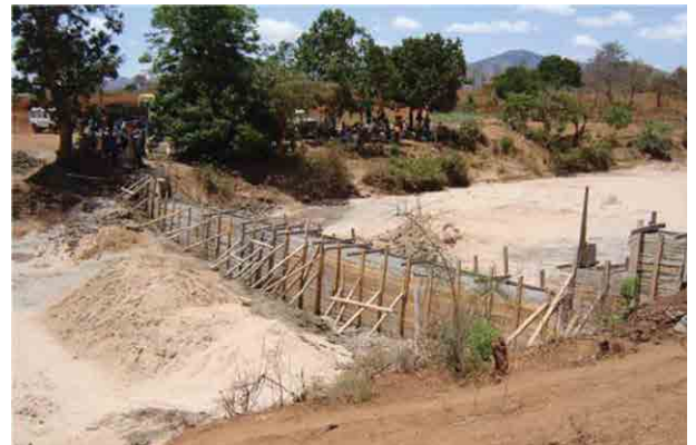
Figure 6. Un barrage de sable achevé en phase de durcissement à Woni Wo Tithi au Kenya
