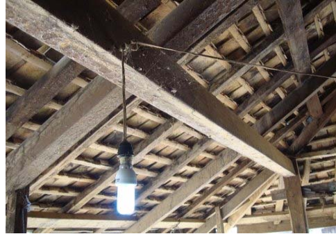
แสงไฟจากเครื่องปั่นไฟฟ้าพลังน้ำ
