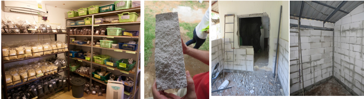
(Dari kiri ke kanan): kawasan penyimpanan benih di ruang lama, bata ringan AAC dari dekat, ruang pendingin baru saat sedang-dibangun, dan ruang pendingin baru saat temboknya sudah selesai tetapi belum dipasang insulasi.
