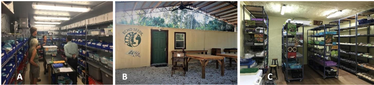
ภาพที่ 1: (A) ห้องเย็นของธนาคารเมล็ดพันธุ์เอดโค โกลบอล ฟาร์ม ควบคุมอุณหภูมิและความชื้น (B) ห้องเย็นตู้คอนเทนเนอร์เอดโค โกลบอล ฟาร์ม ดัดแปลงจากตู้คอนเทนเนอร์เก็บความเย็น (C) ห้องเย็นบุโฟมและควบคุมความเย็นด้วยเครื่องปรับอากาศแบบแยกส่วน เอดโค เอเชีย อิมแพค (ภาพโดย Holly Sobetski/Elizabeth Casey)
