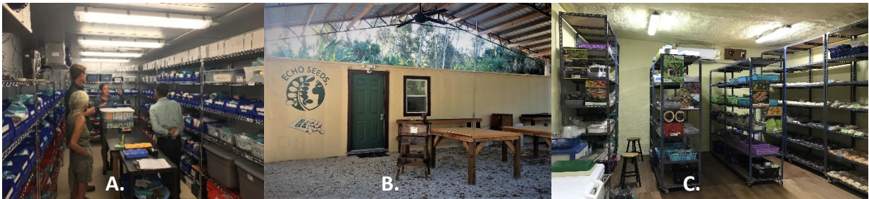
ပုံ ၁။ (က) အီးစီအိပ်ချ်အို ကမ္ဘာလုံးဆိုင်ရာလယ်ယာအစေ့ဘဏ်အအေးခန်း၊ အပူချိန်နှင့်စိုထိုင်းခြင်းအတွက်ရာသီဥတုထိန်းခြင်း။ (ခ) အီးစီအိပ်ချ်အို ကမ္ဘာလုံးဆိုင်ရာလယ်ယာကွန်တိန်နာအအေးခန်း၊ ပြန်လည်တတ်ဆင်၍အအေးခတ်ပေးထားသည့်ပို့ဆောင်သောသေတ္တာ(ကွန်တိန်နာ)။ (ဂ) အီးစီအိပ်ချ်အိုအကျိုးသက်ရောက်မှုစင်တာ၊ ရေမြုပ်အပူစီဆင်းမှုထားဆီးခြားထားသည့်-ယူနစ် A/C အအေးအခန်း (ခါတ်ပုံခရက်ဒစ် ဟော်လီ ဆိုဘက်စကီ/အဲလစ်စဘက် ကာစေး)။
