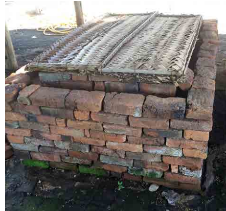
Figure 8. Une chambre de refroidissement par évaporation à l'AVRDC en Tanzanie, faite de briques. Source: Stacy Swartz
