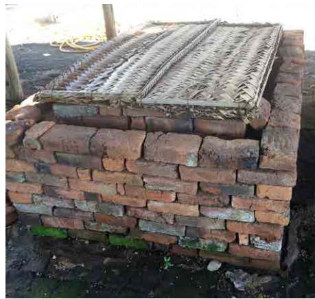
Figura 8. Cámara de enfriamiento por evaporación en AVRDC en Tanzania, hecha con ladrillos. Fuente: Stacy Swartz
