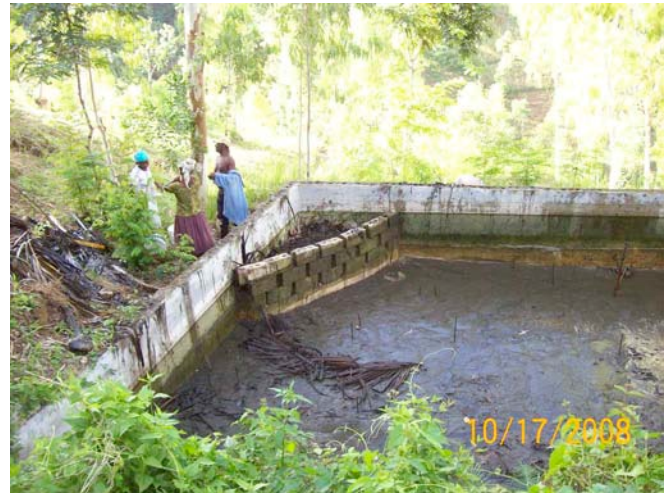
Figura 3. Un estanque seco mostrando el contenedor de compost en la esquina superior izquierda. Foto de William Mebane.
